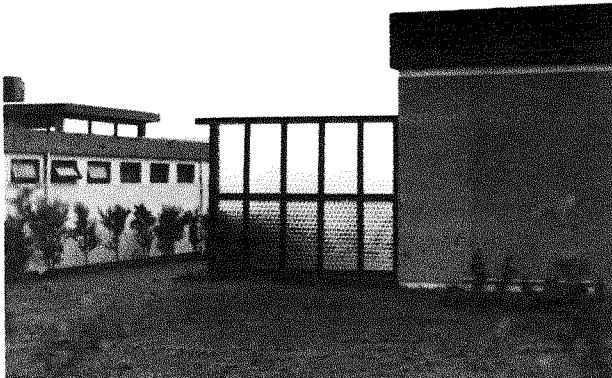
Mynd 2. Trégrindarveggur klæddur mýnstruðu gleri
